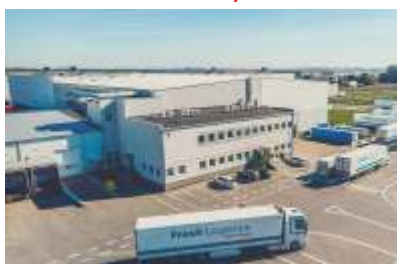
CENTRUM LOGISTYCZNE AUCHAN, WOLBÓRZ
